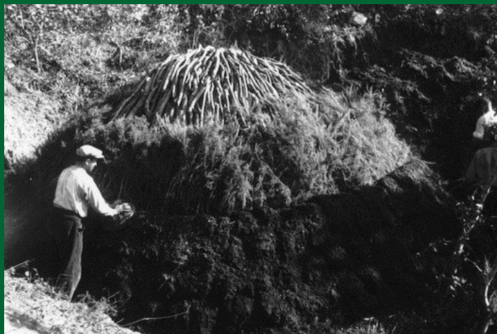
Imatges de tres fases per elaborar carbó vegetal: la pila de fusta, el cobriment de matolls i terra, i la cocció. Fotos: moiadabans.blogspot.com.
