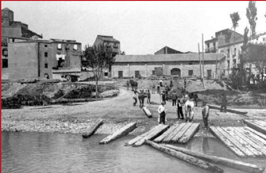
Tramada de rai desmuntada a Lleida, destinats a casa Rossell i Vila (1900-1910). Foto: xarxes socials.
