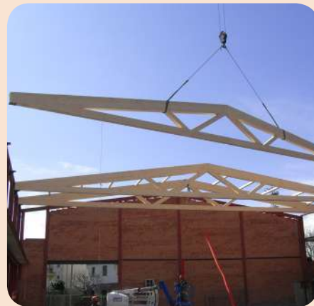
Instal·lació de les primeres encavallades de la coberta
