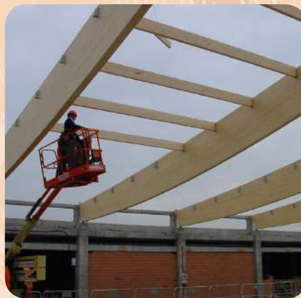
Instal·lació de les bigues de la coberta
