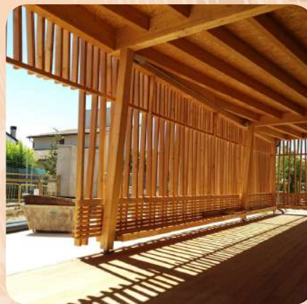
Vista interior de l'estructura d'entramat lleuger
