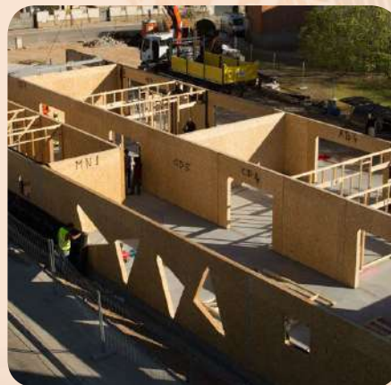
Vista general de l'estructura de l'escola bressol durant el muntatge
