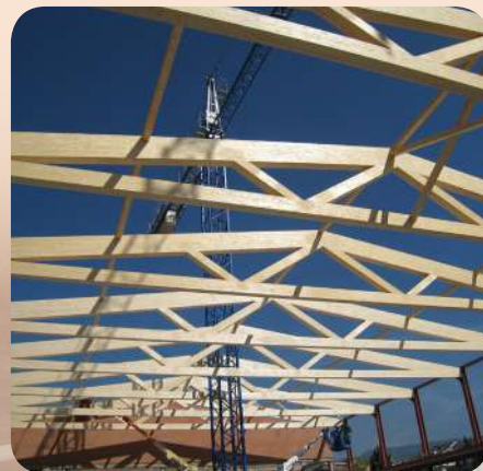
Encavallades de la coberta un cop instal·lades
