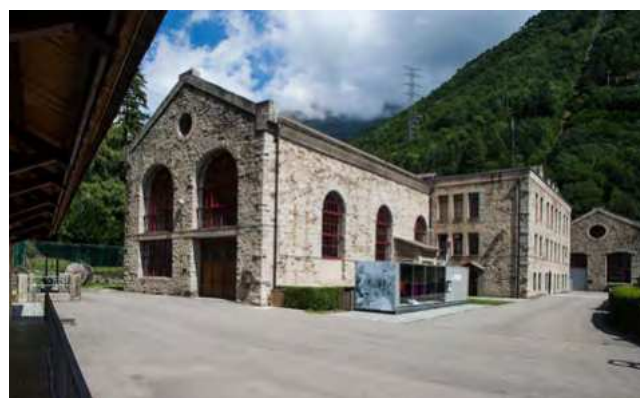
Museu Hidroelèctric de Capdella i central hidroelèctrica.
