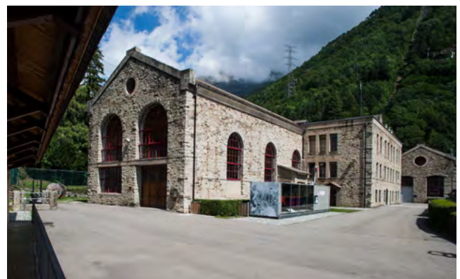
Museu Hidroelèctric de Capdella i central hidroelèctrica.
